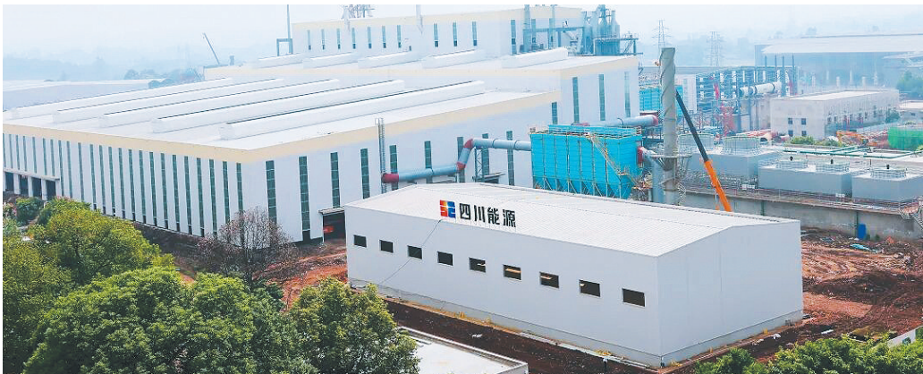
四川能源钢铁公司节能降碳技改项目总体工期进度80%,为冲刺全年目标打下坚实基础。
