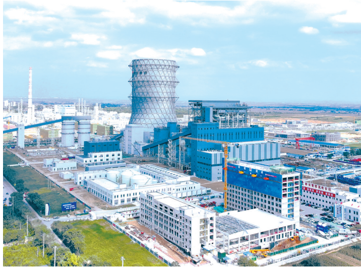
陕煤彬长矿业660MW超超临界CFB示范项目
