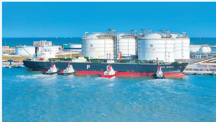
滨化股份源网荷储一体化项目
