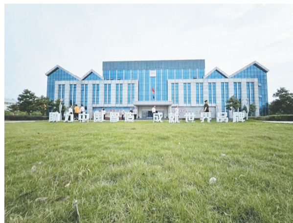
京山市智能装备产业园内京山轻机办公楼
