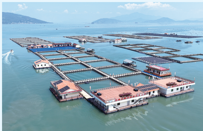
位于宁德三都澳的海上渔排“风、光、储、充、用”微电网。 黄海/摄
