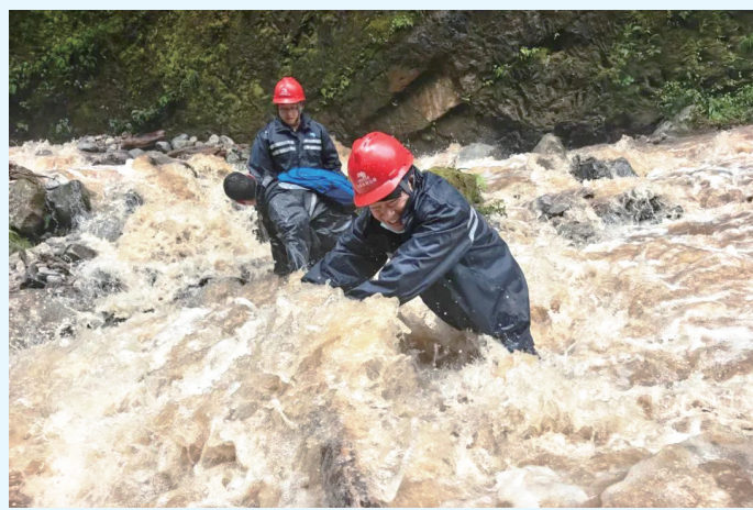
南方电网云南电网公司抢修人员在徒步进入独龙江乡途中遇到湍急浑浊的河流,他们手搭一根木头,相互协作,艰难蹚水过河,无畏风雨与激流,全力守护电力供应。
