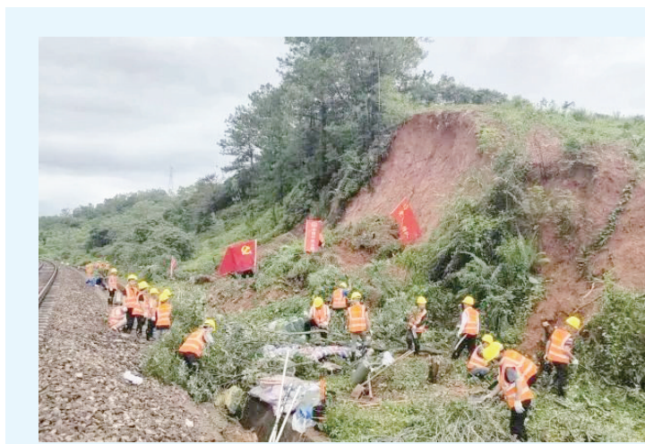
中国中铁救援抢险人员开展道路清障工作。
