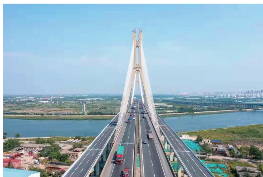
长深高速公路扩建工程海河特大桥建成通车
