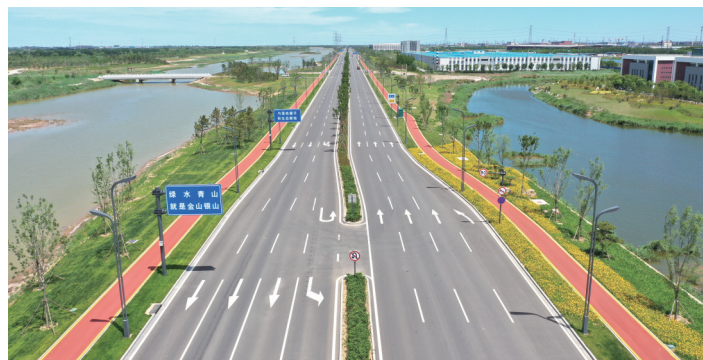
建成通车后的北二路沿线及金湖银河航拍
