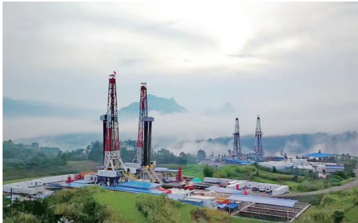
页岩气工厂化钻井作业现场
