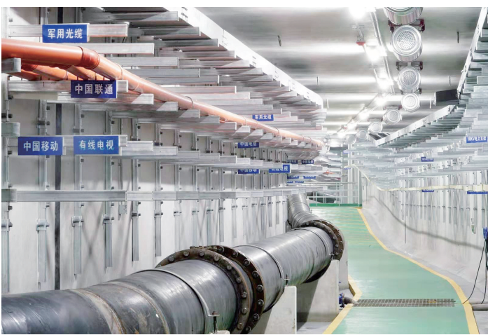
海口地下综合管廊项目
