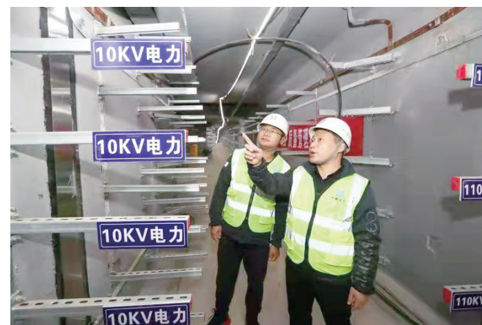
杨岸峰(右)在施工现场
