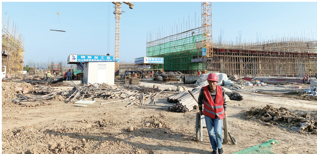
正在建设中的中国电信(安徽)大数据产业园 吴明/摄
