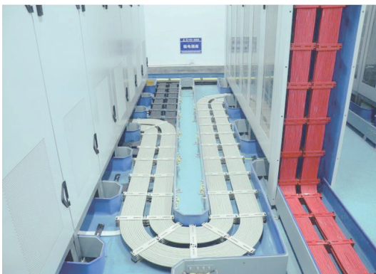
信号设备室线缆布设
