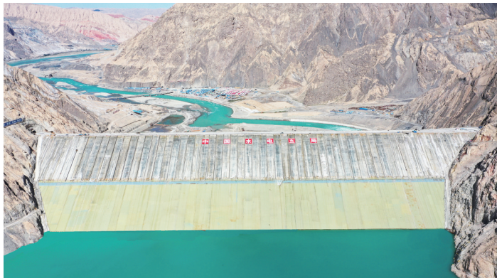
中国水电五局承建阿尔塔什水利枢纽大坝工程
