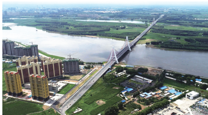
松原市天河大桥全景
