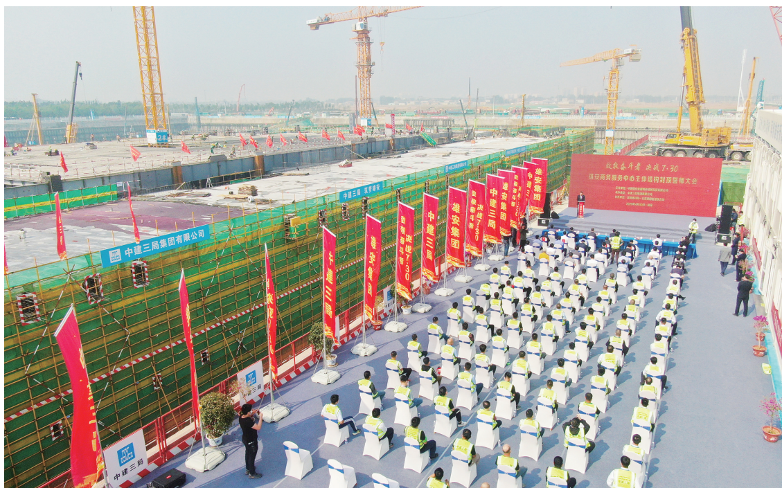
雄安商务服务中心项目主体结构封顶誓师大会
