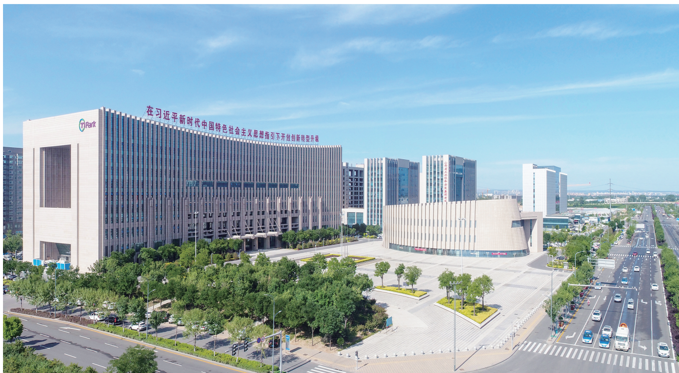
山西转型综合改革示范区政务服务中心
