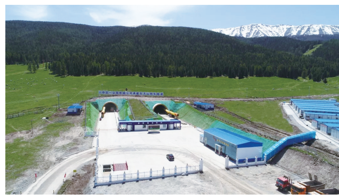
东天山隧道进口段主洞全景图
