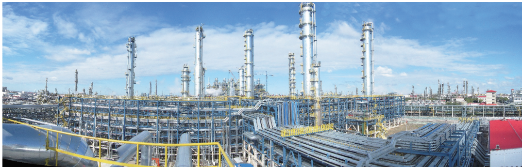
大庆乙烯项目全景
