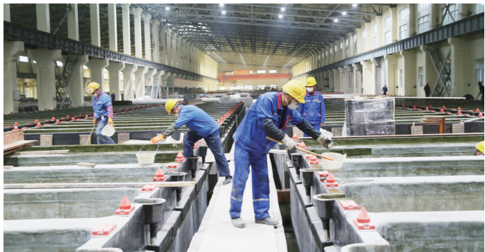
金冠铜业分公司奥炉电解二期工程建设现场,施工人员正在抢抓时间进行施工。 吴家富/摄
