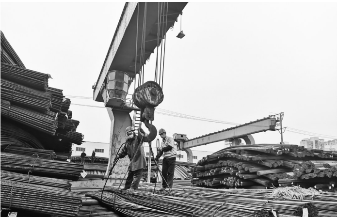
3月13日下午,徽商金属物流公司货场,工人正在紧张进行螺纹钢装车作业。
