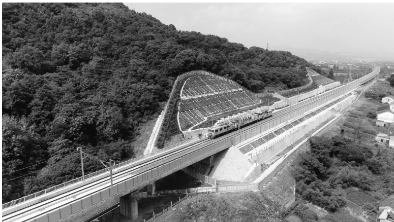
“杭黄客专示范工程”接触网作业
