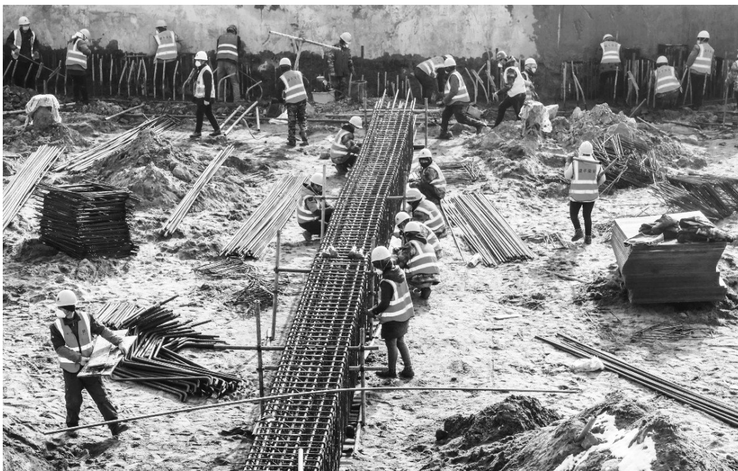
北京城市副中心剧院、图书馆、博物馆三大建筑工程已全面复工
