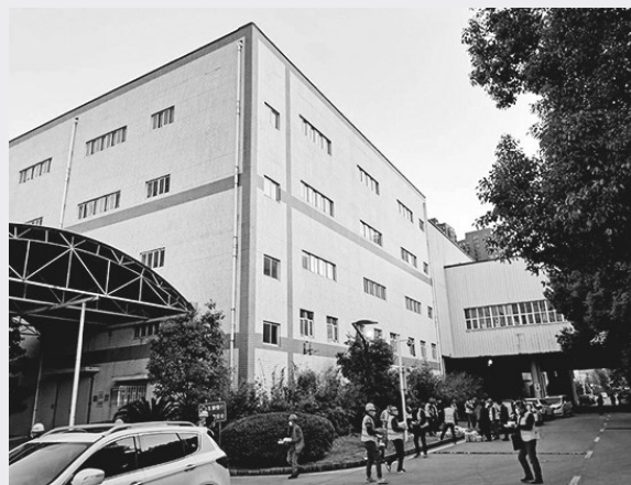
2月21日4时30分,中国电建水电四局武汉方舱医院援建小分队再交战果:经过10小时挑灯夜战,紧急援建的武汉卷烟厂方舱医院项目圆满完成。
