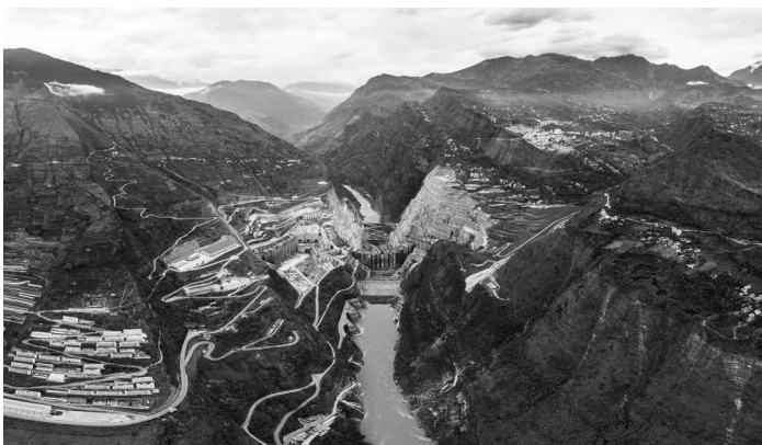
航拍施工区全景 彭宏义 朱永祥/摄
