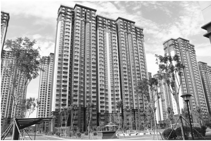
吴家堡安置房项目实景
