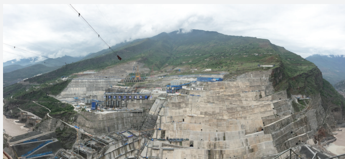
施工局承建白鹤滩电站左岸施工全貌
