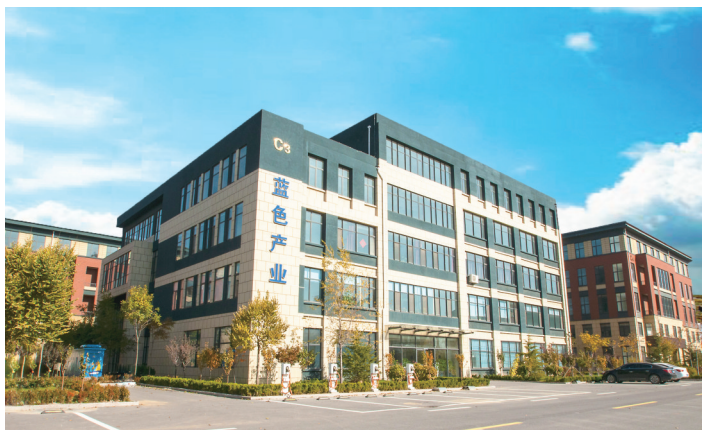
青岛费米新材料科技有限公司办公楼
