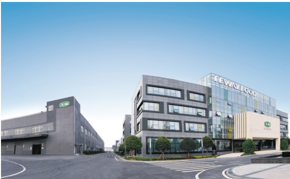
四川天味食品集团股份有限公司办公楼
