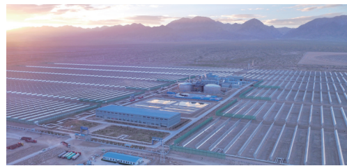
德令哈光热项目航拍图
