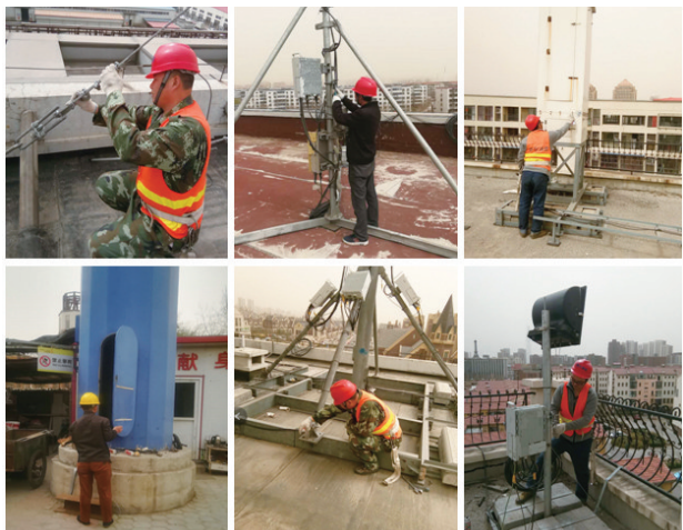
铁塔项目现场
