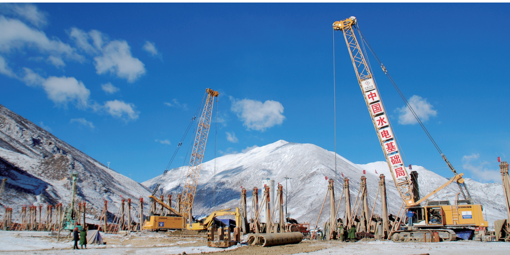
西藏旁多水利枢纽防渗墙工程,创造201米单槽深墙世界纪录。
