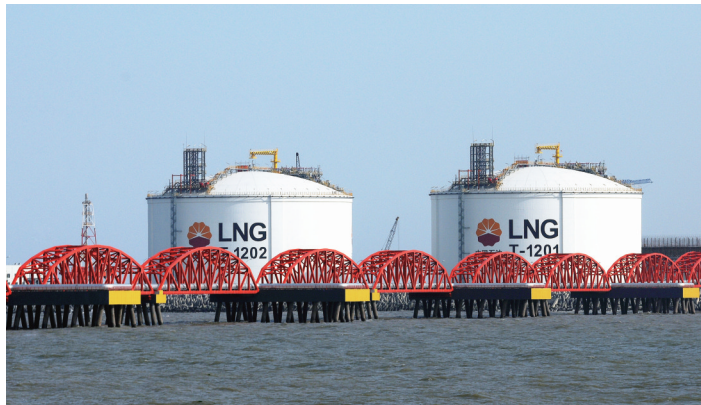
2016年11月3日,中石油江苏LNG项目有效容积20万立LNG储罐一次投产成功。
