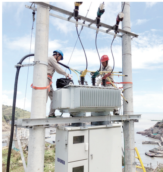
施工人员紧张修复台风受损台区 蔡文谨/摄
