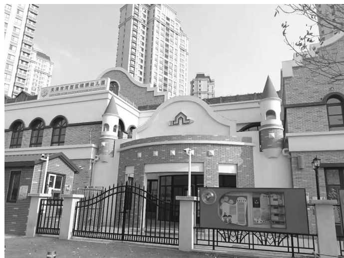
天津河西一幼锦绣幼儿园成为首批安装新风系统的公立幼儿园
