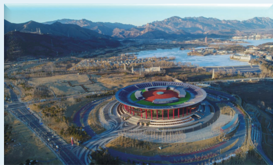
2014北京APEC会场雁栖湖国际会展中心
