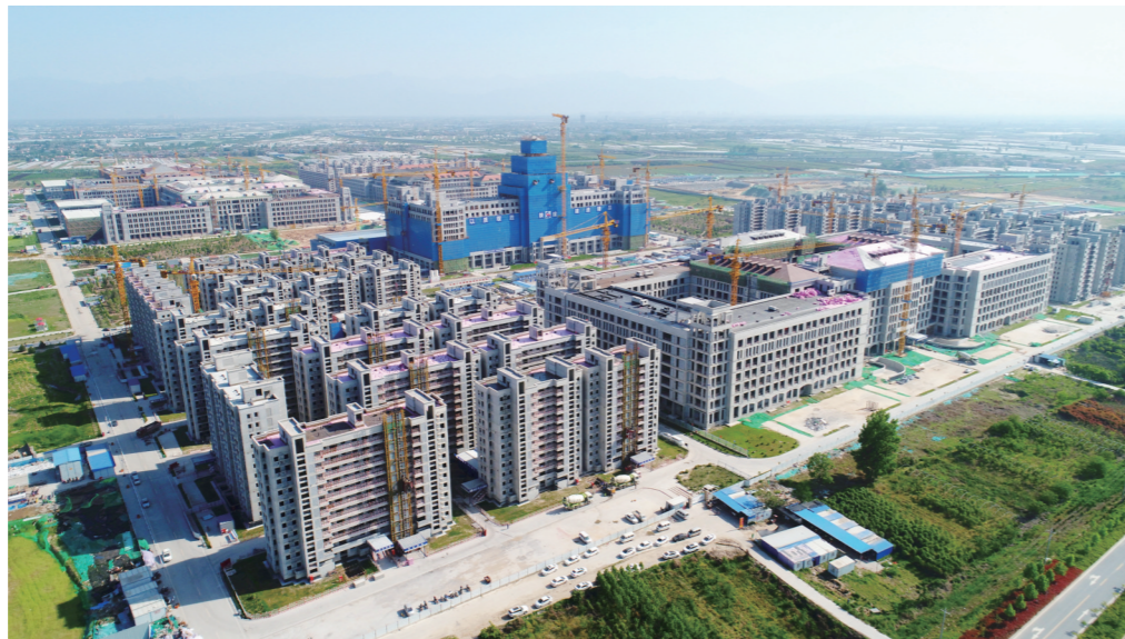
正在建设的中国西部科技创新港(建筑面积159万平方米)
