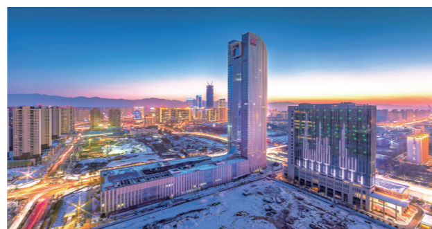
延安石油科研中心(高217米)
