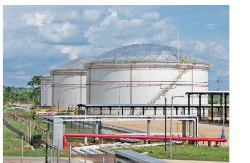
加纳库马西油罐工程(境外鲁班奖)
