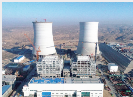
正在建设的榆能横山煤电2×1000MW项目
