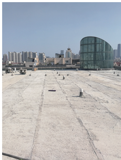
修复后的老旧建筑屋顶达到了百年不漏水、不着火的效果。
