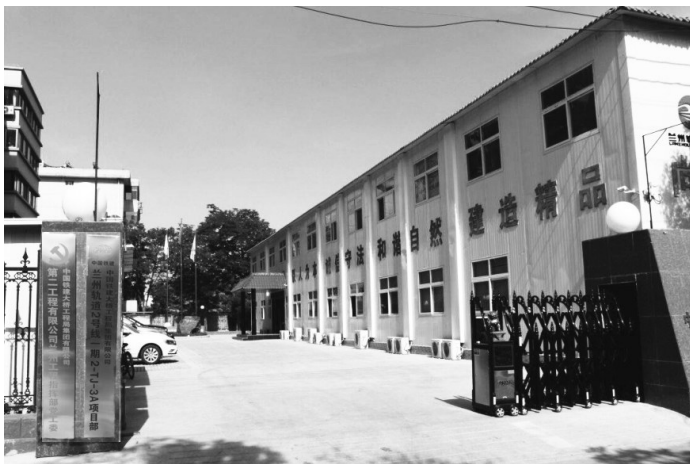
中国铁建大桥工程局兰州轨道2号线一期2-TJ-3A项目部
