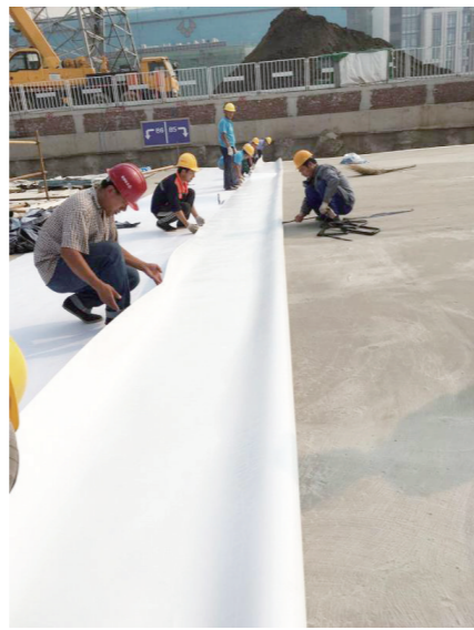
高分子防腐防水材料在北京城市副中心地下交通环路项目中应用
