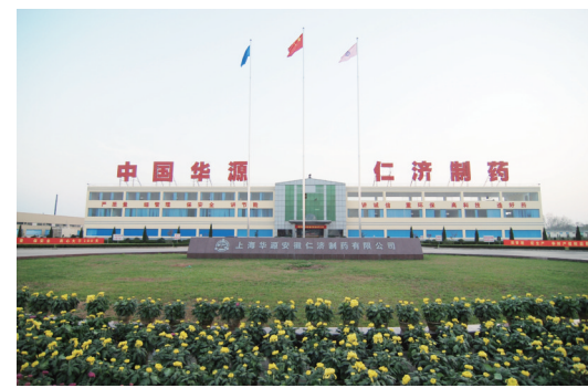
安徽华源医药下属仁济制药厂区
