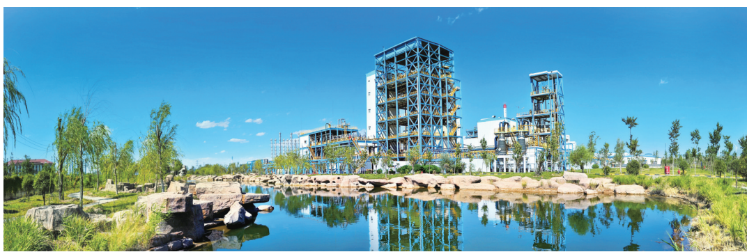
新特能源股份有限公司循环经济景观池
