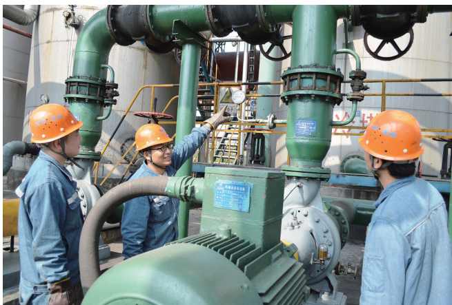
淮北矿业临涣焦化公司化产车间技术工人余海涛(左二)在向工友讲解设备保养维护知识 魏玉东/摄
