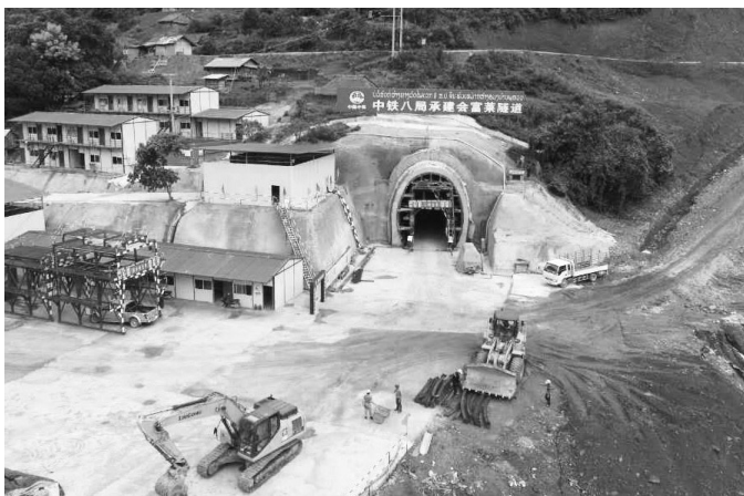
八局一分部承建会富莱隧道
