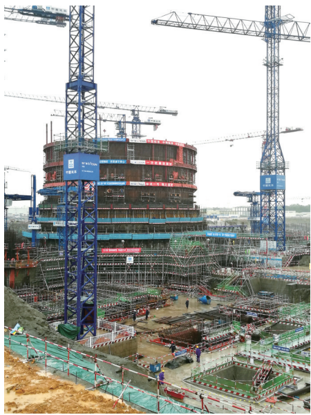
建设中的“华龙一号”
