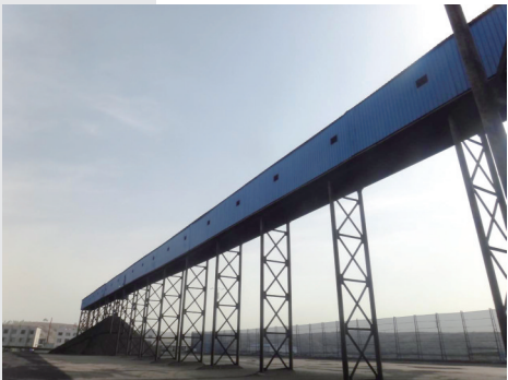
密闭输煤走廊
