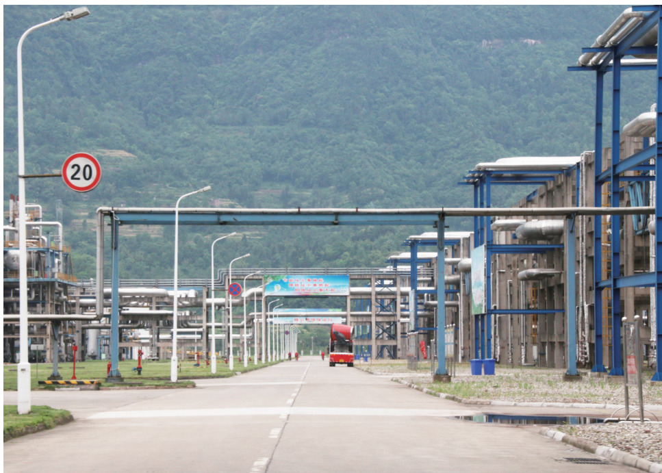
普光气田净化厂厂区
