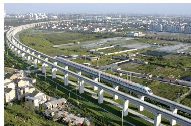
中铁宝桥参建的上海高速磁悬浮运营线
