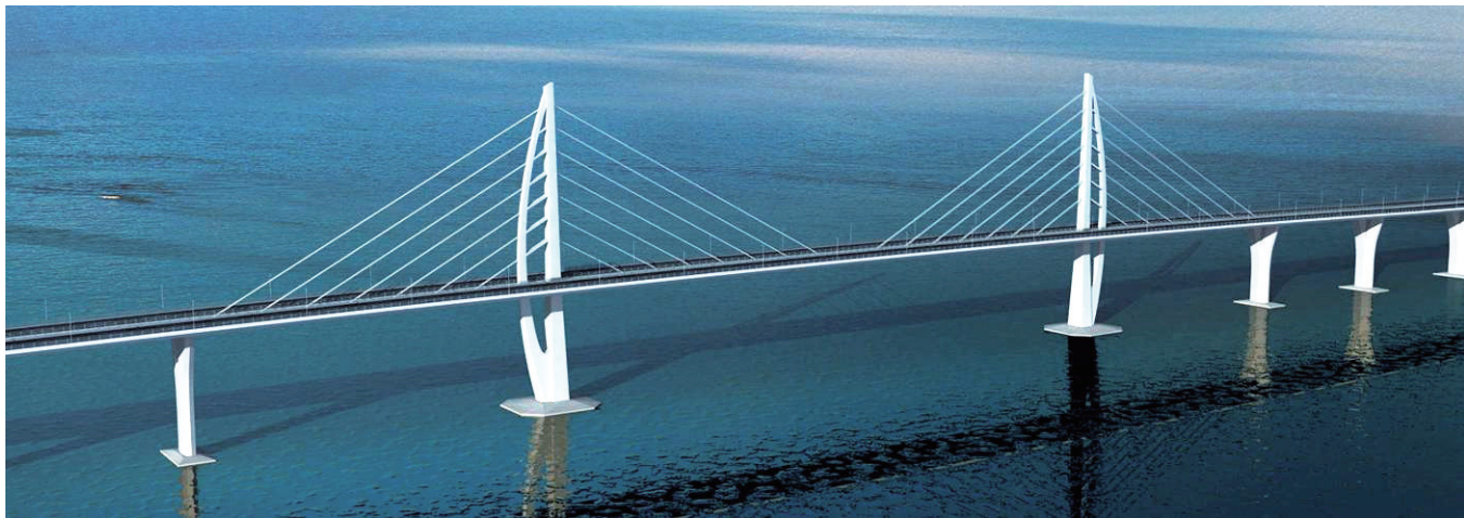
中铁宝桥参建的世界最大桥梁——港珠澳大桥(在建)
