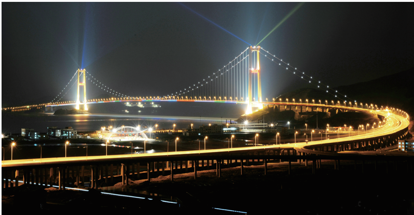
中铁宝桥参建的舟山连岛工程——舟山西堠门大桥
