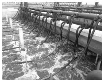
圣捷污水处理厂化工废水处理项目
